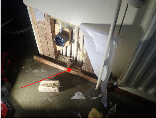
Näyte U1 otettiin rakennusavauksesta RA1 ulkoseinärakenteesta.
