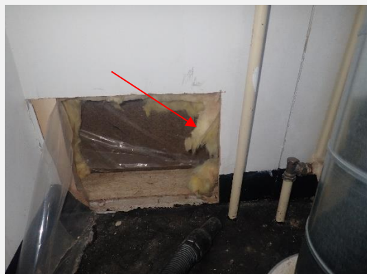
Näyte U6 otettiin IV-konehuoneen ulkonurkan eristeestä, RA6.
