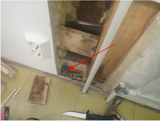
Näyte U7 otettiin opetustilan ulkoseinän alaosasta, RA7.
