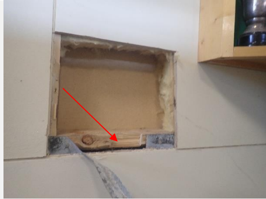
Näyte U2 otettiin portaikon väliseinästä, RA2.
