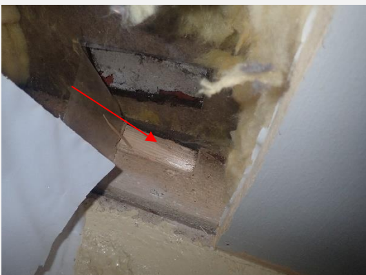
Näyte U5 on otettu kerhotilan ulkoseinän alaohjauspuusta, RA5.
