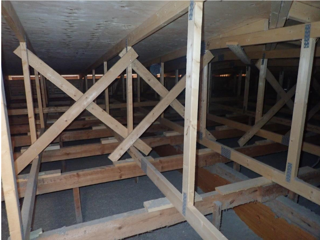
Yläpohja oli rakenteineen erinomaisessa kunnossa, eikä yläpohjan osalta ole havaittu vesivuotoja katteessa.
