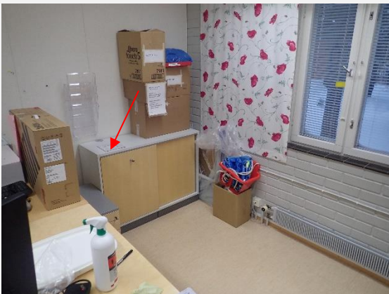
Näyte SK 9 otettiin toimistohuoneen lipaston päältä
