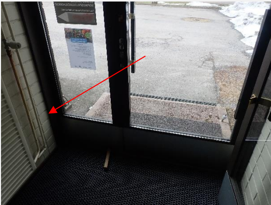
Näyte NK7 otettiin paloseman tuulikaapin ulkoseinä-rakenteesta, RA7.
