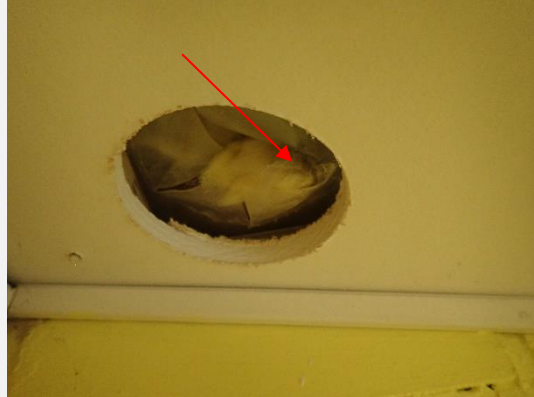
Näyte NK2 otettiin yläpohjan mineraalivillasta, RA2.
