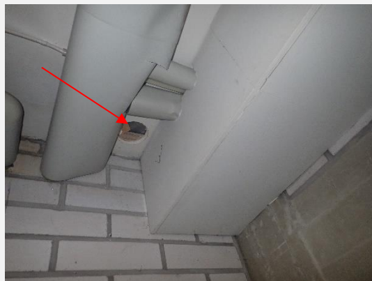
Näyte NK6 otettiin paloaseman kalustonhuoltotilan sisäkatoista, RA6.
