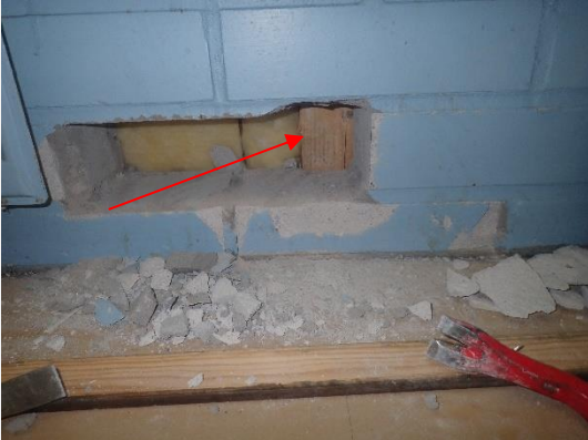
Näyte NK1 otettiin rakenneavauksesta RA1 ulkoseinärakenteesta.
