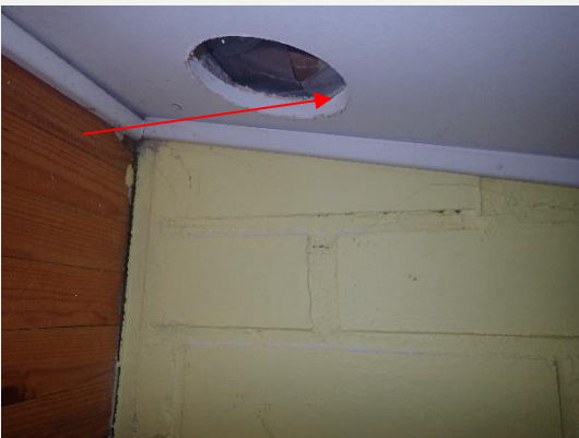
Näytet NK3 otettiin salin yläpohjan kipsilevystä, RA3.
