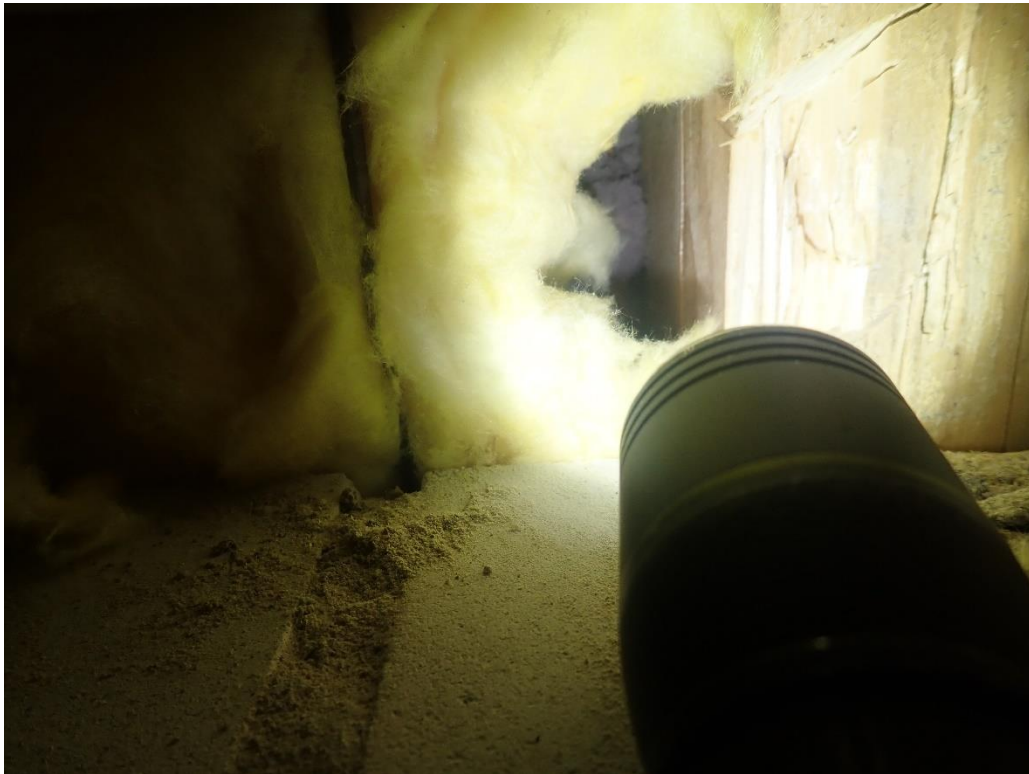
Ulkoseinärakenteet tutkittiin ulkokuoreen asti
