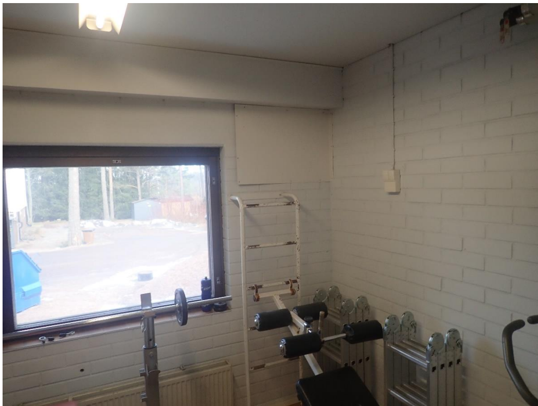
Liikuntatilan seinässä on vanha ilmanvaihtoaukko peitetty peltilevyllä.
