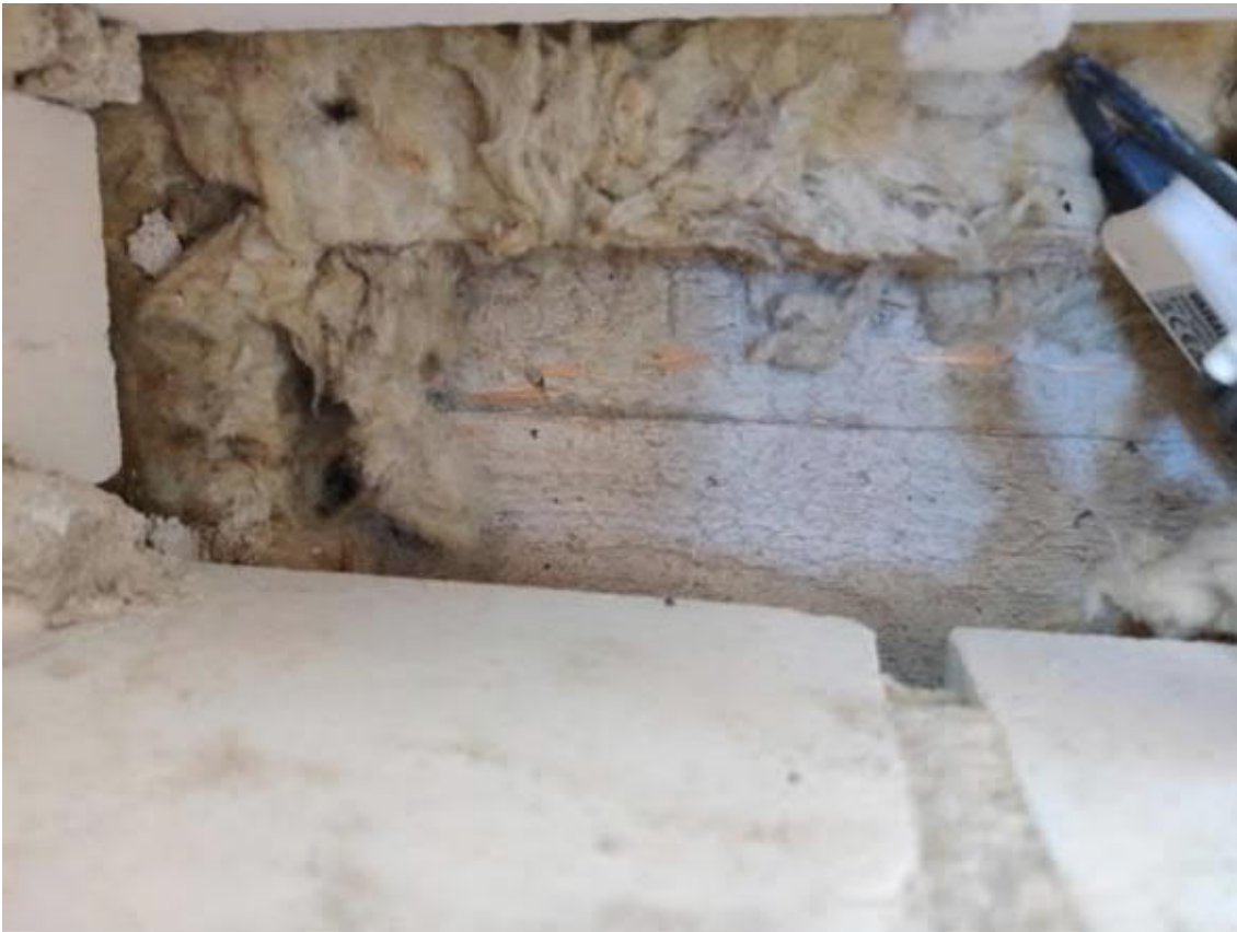
Kuva 16 Sokkelirakenne Sk2. Rakenne oli suunnitelmien mukainen. Eristekerroksesta ei havaittu kohonneita kosteuspitoisuuksia avauksen kohdalla.
