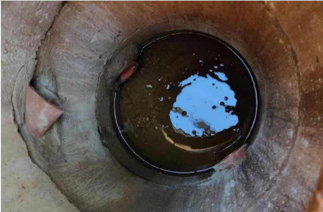
Kuva 6. Salaojakaivosta havaitut salaojaputket olivat tiilestä valmistettuja ns. ruukkuputkia. Liete- pesät olivat tutkituissa kaivoissa puhtaat. Vedenpinta oli salaojaputkien alapuolella kaikissa tarkas- tetuissa pisteissä.
