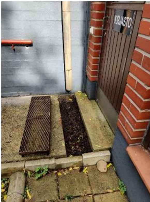
Kuva 11. Kirjaston edustan sadeveden ohjaus oli puutteellinen. Sadevesikouru oli täynnä roskia ja vesi oli johdettu rakennuksen vierustalle. Syksyputken alla betoniseinässä näkyy vanhan puisen muottivälikkeen muodostama reikä sokkelin sisään.
