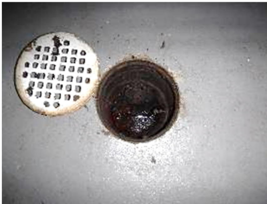
Kuva 86. Lämmönjakuhuoneen lattiakaivo.
