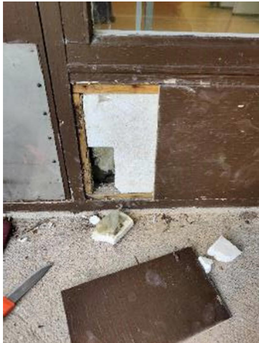
Kuva 15. Sokkelirakenne Sk1. Kirjaston parvekkeen sisäänkäynnin kohdalla olevan puurakenteisen elementin sokkelirakenteeseen tehtiin avaus. Rakenteen eristekerroksesta havaittiin tummentumia.
