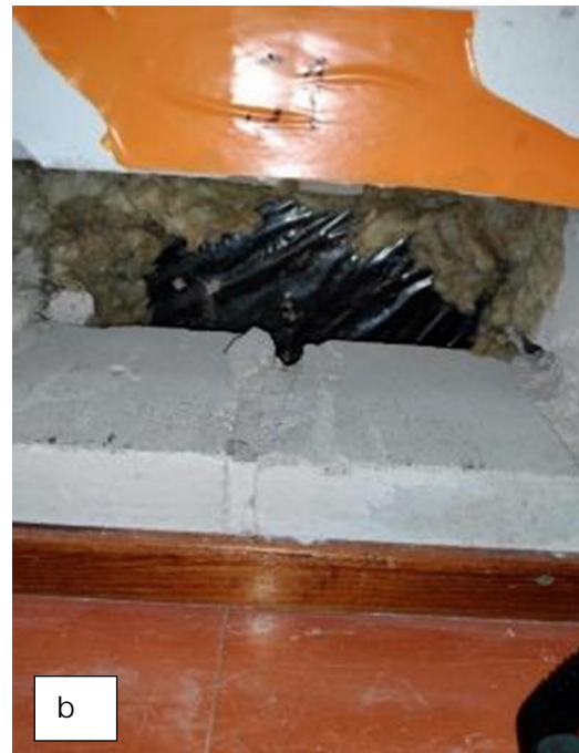
Kuva 22. Kuva a; rakenneavaus M1. Seinän ja betonilaatan liitoskohdassa havaittiin betonilaatan kutistumasta johtuvia rakoja. Kuva b; Maanvastainen seinärakenne MS1. Rakenteen eristekerroksen ja vedeneristekerroksen välissä on muovikalvo.
