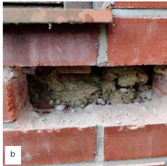
Kuva 48. Rakenneavaus U7. Otetussa mikrobinäytteessä ei ollut aktiivista kasvua.
