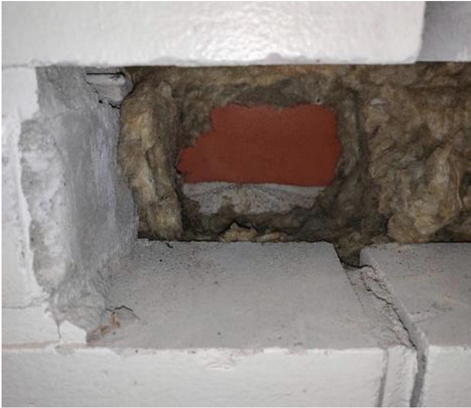
Kuva 48. Rakenneavaus U7. Otetussa mikrobinäytteessä ei ollut aktiivista kasvua.
