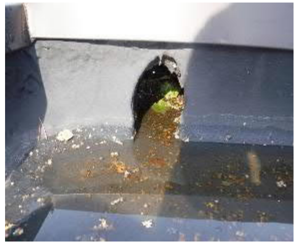
Kuva 9. Sadevedet oli ohjattu korkeammalta katto-osuudelta matalampaan erillisillä sadevesiputkilla. Vettä makasi molempien korkeamman osan poistoputkien suuaukolla ja toinen putkista oli tukkeessa.
