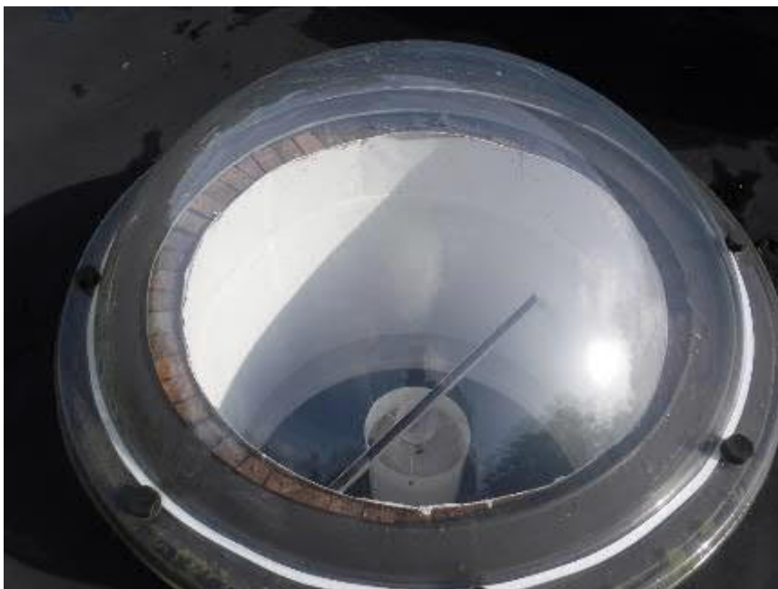
Kuva 73 Kattoikkuna katolta kuvattuna. Rakenteen runkona toimii vierekkäin asennetut puurimat, joiden pintaan on asennettu ohut vaneri.
