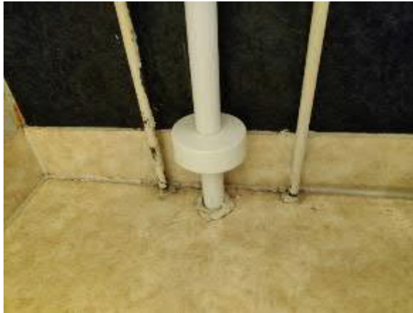
Kuva 79. Auenneita saumauksia ja epätiiveweys- kohtia wc:ssä.
