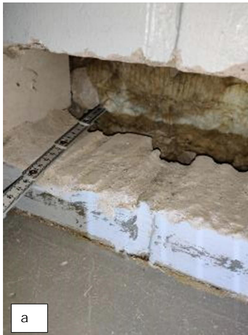
Kuva 22. Kuva a; rakenneavaus M1. Seinän ja betonilaatan liitoskohdassa havaittiin betonilaatan kutistumasta johtuvia rakoja. Kuva b; Maanvastainen seinärakenne MS1. Rakenteen eristekerroksen ja vedeneristekerroksen välissä on muovikalvo.
