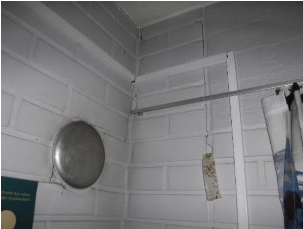
Kuva 82. Korvausilmaventtiili seinässä.
