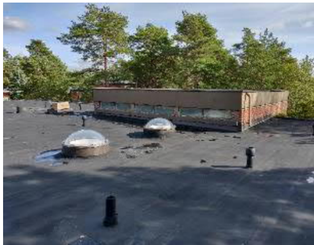
Kuva 9. Sadevedet oli ohjattu korkeammalta katto-osuudelta matalampaan erillisillä sadevesiputkilla. Vettä makasi molempien korkeamman osan poistoputkien suuaukolla ja toinen putkista oli tukkeessa.
