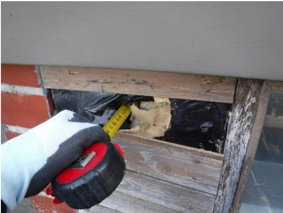
Kuva 51. US2 rakenne istuntosalin yläikkunoiden vieressä.
