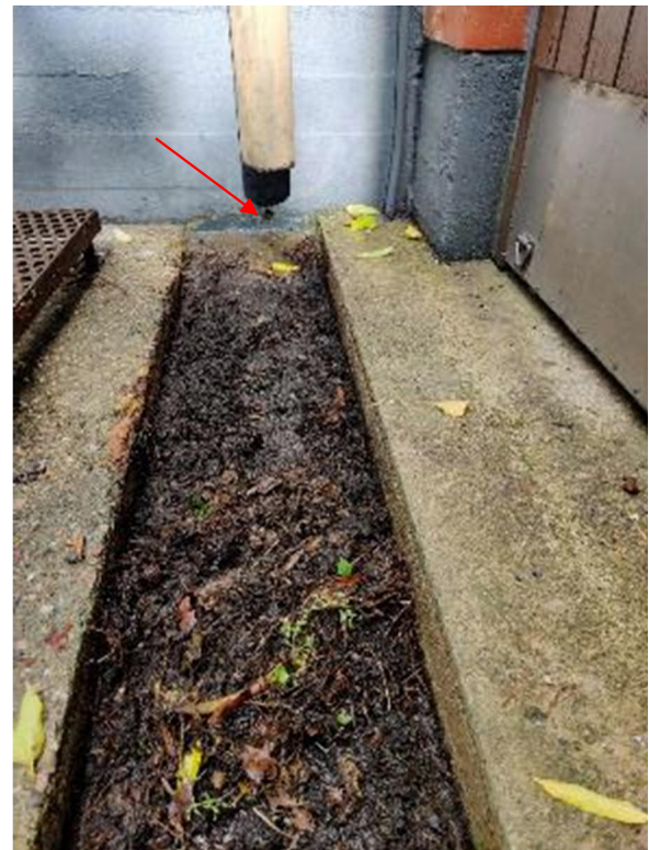
Kuva 11. Kirjaston edustan sadeveden ohjaus oli puutteellinen. Sadevesikouru oli täynnä roskia ja vesi oli johdettu rakennuksen vierustalle. Syksyputken alla betoniseinässä näkyy vanhan puisen muottivälikkeen muodostama reikä sokkelin sisään.
