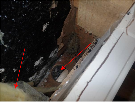
Näytteet KM1 ja KM2 otettiin rakenneavauksesta RA1 ulkoseinärakenteesta.
