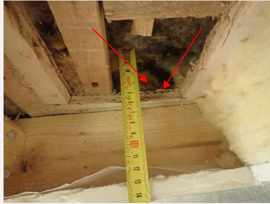
Näytteet KM3 ja KM4 otettiin käytävän rakenneavauksesta RA2. ulkoseinärakenteesta.
