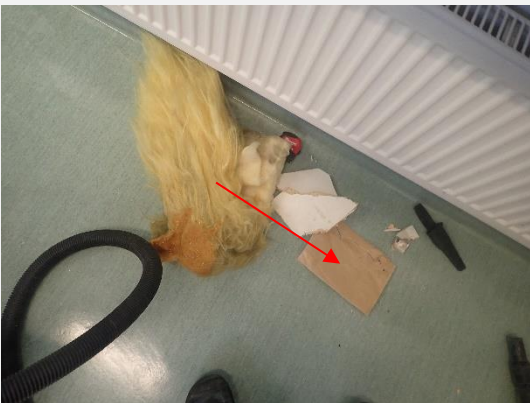
Näyte KM9 on otettu luokan (Kaurissalo) ulkoseinän ilmansulkupaperista. (RA5)
