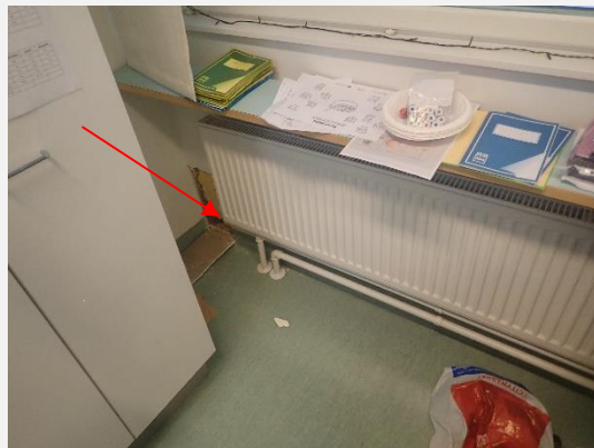
Näyte KM10 otettiin luokan (Isoluoto) ulkoseinän mineraalivillaeristeestä. (RA6)
