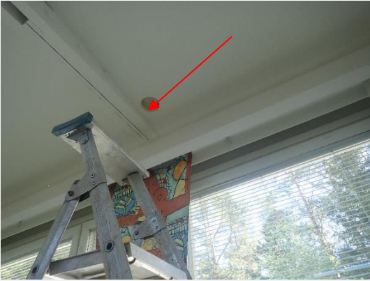
Näyte N1 otettiin koululuokka kaurissalon yläpohjasta.
