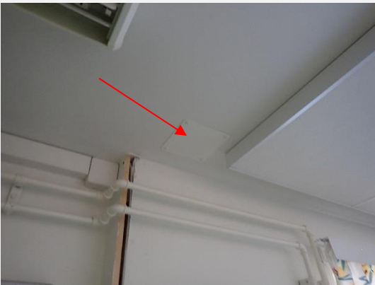
Näyte N5 on otettu luokan (Vartsala) yläpohjasta
