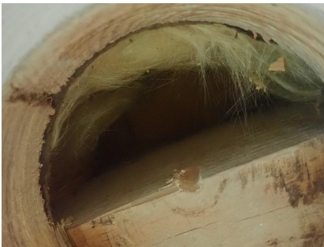
Rakenneavaus kohdasta (RA5)
