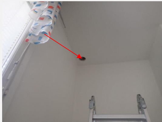
Näyte N6 otettiin opettajainhuoneen yläpohjasta.
