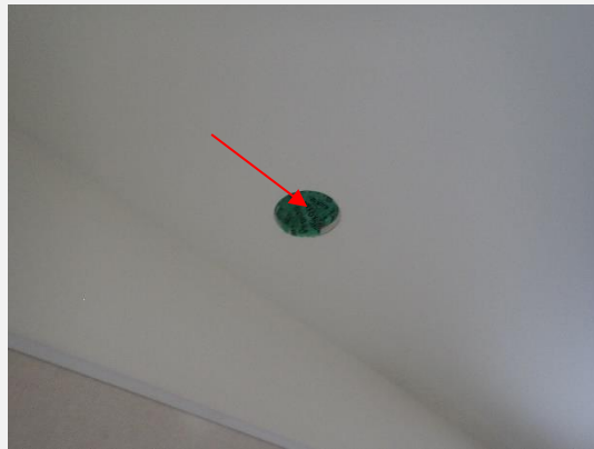
Näyte N4 otettiin kuraattorin huoneen yläpohjasta.
