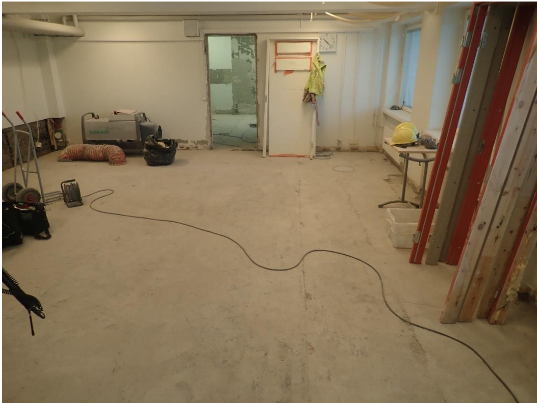
Kellarikerroksen lattia ja seinärakenteita oli purettuna
