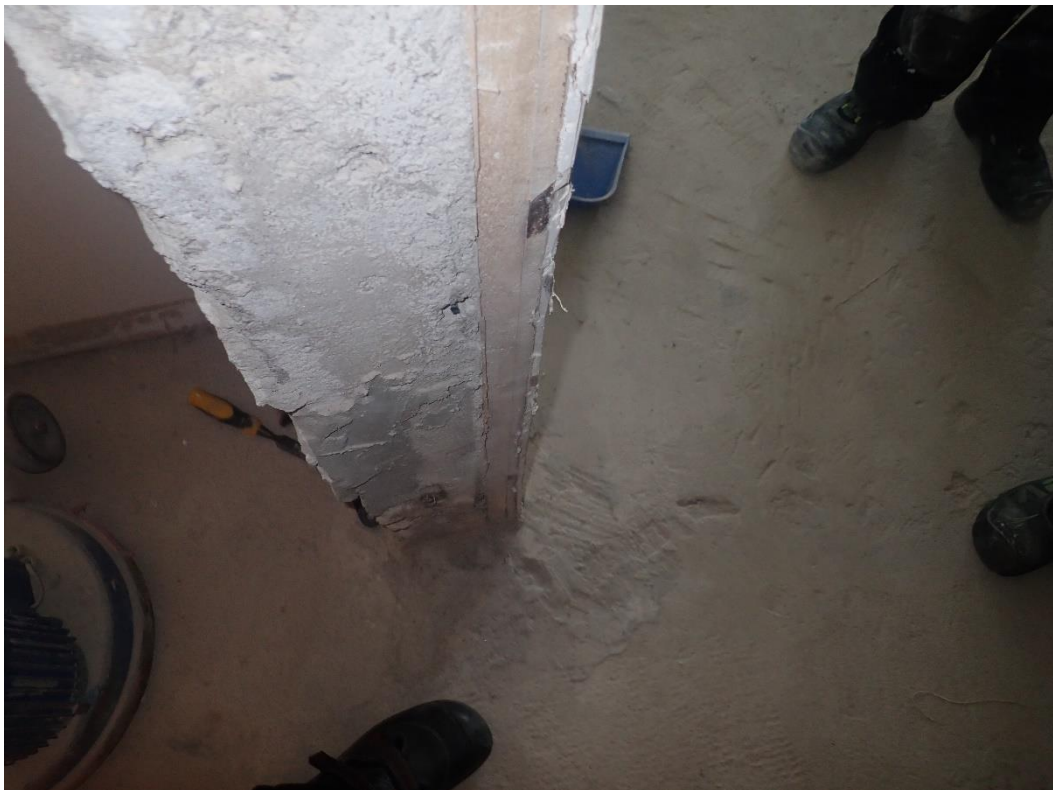
Ohjeistuksena on purkaa kaikki orgaaninen materiaali, joka on kytköksissä betonirakenteeseen.
