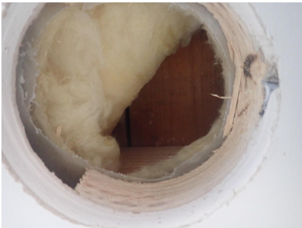
Rakennekerrokset tutkittiin rakenneavausten kautta
